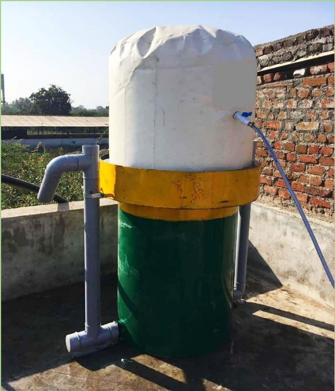
**Fig : Biogas Plant**
